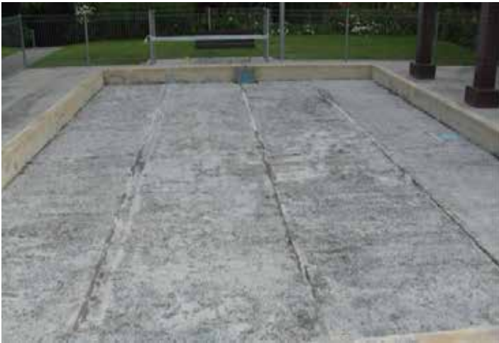
07.30am Se comienza la impermeabilización
